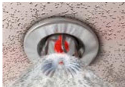
スプリンクラーバルブ:一定した信頼できる熱膨張性を持つデュラン®ガラス管
